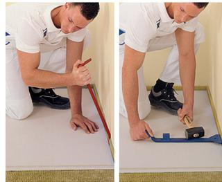
Die Randplatten können mit Hilfe eines Zugeisens oder Montiereisens leicht eingesetzt werden. Nach Abschluss der Arbeiten müssen evtl. gesetzte Keile wieder entfernt werden.
