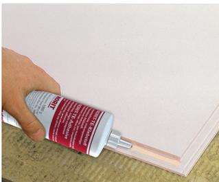
Die Verbindungsflächen müssen trocken, staub- und fettfrei sein und dürfen nicht beschädigt sein. Der Klebstoff wird auf die Anlegezone des verlegten Elements aufgebracht. Dabei kann die Flasche an der oberen Plattenkante entlang geführt werden, so dass der Klebstoff
