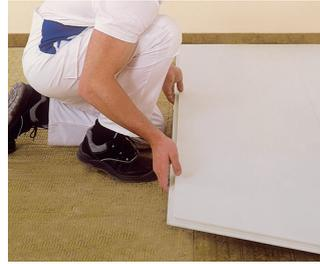
Die Trockenestrichelemente werden schräg angesetzt und dann mit leichtem Druck gegen die bereits verlegte Platte abgelegt. Bei der weiteren Verlegung ist auf eine geschlossene Längsfuge zu achten.
