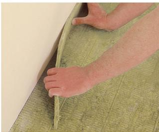
Zur Vermeidung von Schallbrücken und zur Aufnahme von Dehnungen sind Randdämmstreifen je nach Raumgröße anzuordnen (Dicke mind. 10 mm). Derartige Fugen sind auch bei allen angrenzenden Bauteilen, z. B. Heizungsrohren, auszuführen.
