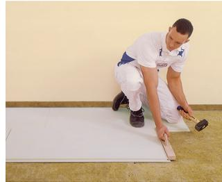
Anschließend werden die Elemente stirnseitig mittels Hammer und NORIT-Haudegen zusammengefügt. Direktes Schlagen mit dem Hammer auf die Trockenestrichelemente kann zu Beschädigungen führen.
